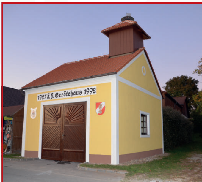
Das Feuerwehrhaus Unterradl nach der Renovierung im Herbst 2011.
